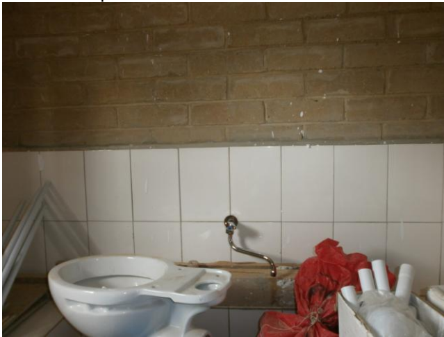
Kraan sluice gemonteerd
