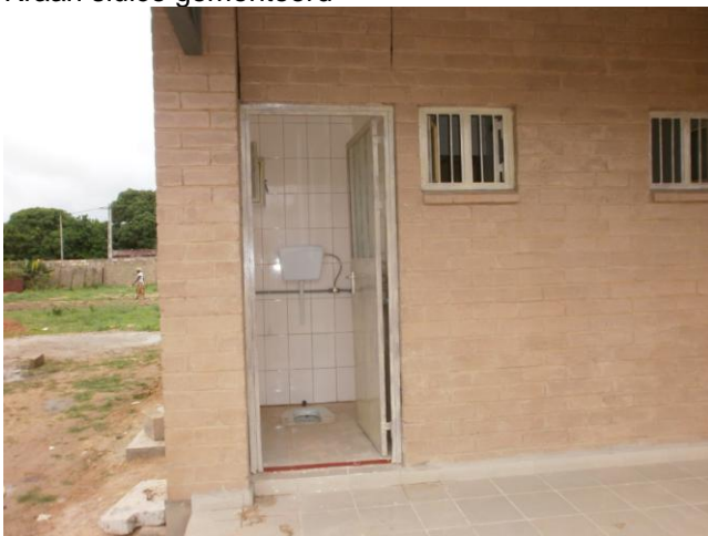
Kozijnen geschilderd, stortbak hurktoilet gemonteerd
