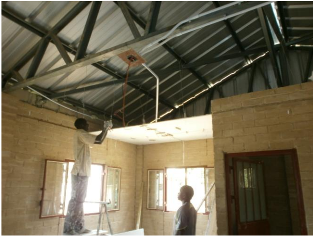
IJzerdraad voor ophangen plafond
