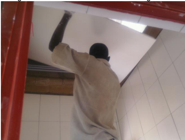
Plafondplaat monteren
