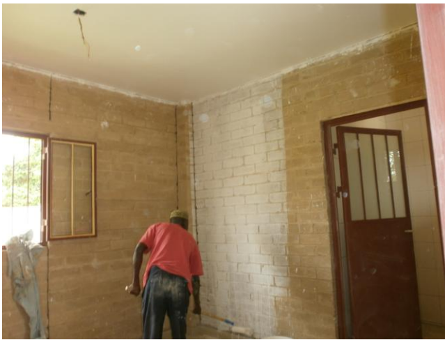
Grondverf op de muren
