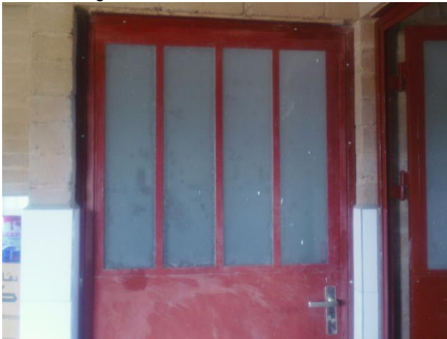
Melkglas voor sanitaire ruimtes en bevallingskamer
