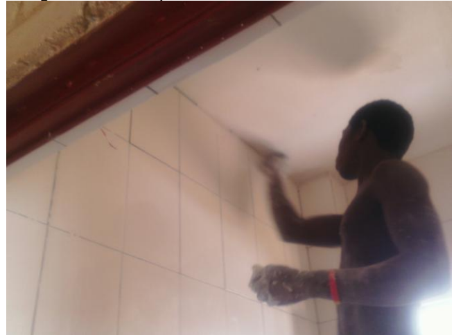
naden plafond afsmeren
